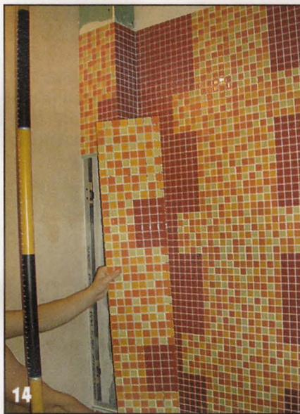
метров до нескольких десятков сантиметров. Я использовал гипсовую смесь фирмы «ОСНОВИТ», так как она быстро твердеет, что позволяет укладывать плитку уже через 3 дня.
