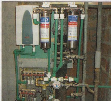
*Выполнено полное подключение горячего и холодного водоснабжения, магистральных фильтров, счётчиков воды и нагревателя воды.*
