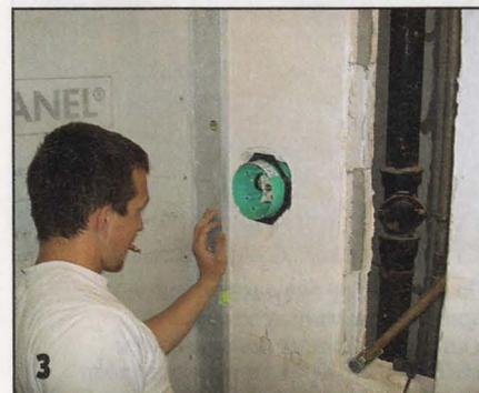
*В стенах ванной прорезал отверстия под вытяжной вентилятор, встраиваемую часть смесителя, а также для небольшого окошка в соседнее помещение.*
