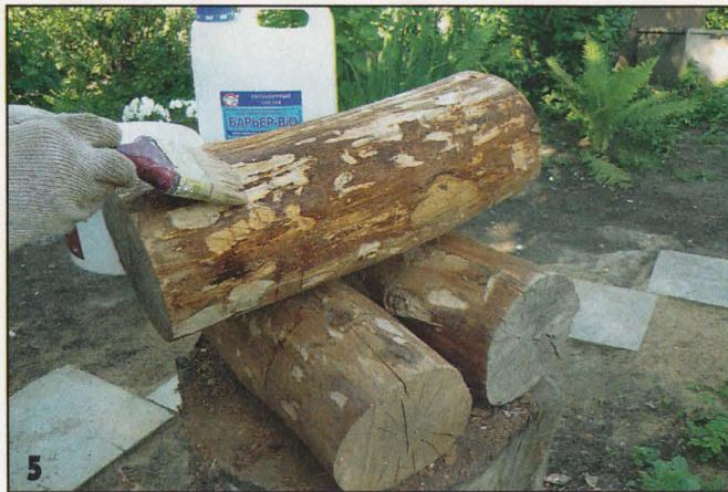
Обработали столбики от гниения и древоточцев антисептиком, который наносили кистью на поверхности столбиков.
