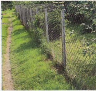
**При правильной установке нижние ячейки рабицы прошиваются проволокой, которую туго натягивают по столбам-опорам.**
