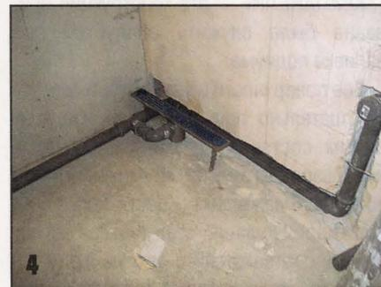
*Трубы слива укладывал в прорезанные в стене штробы. К сливу поддона прикрепил трап с сифоном из нержавеющей стали.*
