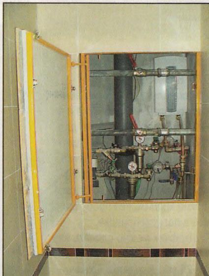
Увеличенный срок службы самого фильтра и отсутствие коррозии внутренних элементов гарантированы благодаря применению при его производстве специальной нержавеющей стали. Фильтр очищает холодную воду от солей жёсткости, ионов железа и тяжёлых металлов, нефтепродуктов, хлора, посторонних запахов, частиц ржавчины и других механических примесей и доводит её качество до уровня питьевой воды.
